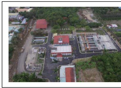
中興新村園區污水處理廠(MBR)
