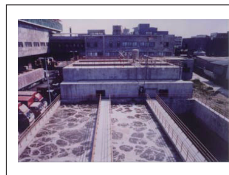
可口可樂飲料廢水處理廠(UASB+AS)
