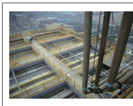
亞東 PTA 石化廠厭氧反應槽工程(UASB)
